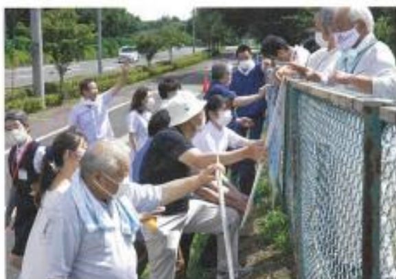
結束バンドでフェンスに看板を設置（大橋愛撮影）
